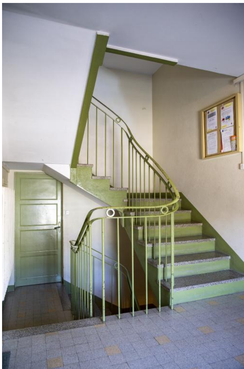
Vue de la cage d'escalier du bâtiment B2.
