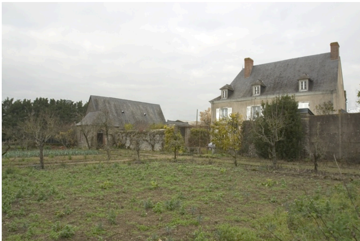
Vue d'ensemble depuis le sud-est : l'écurie et le logis.
