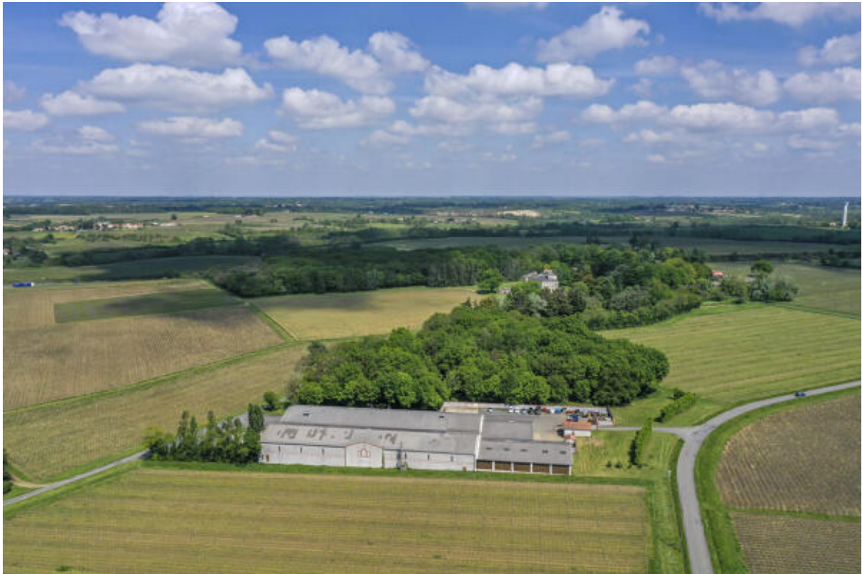
Vue générale du site.
