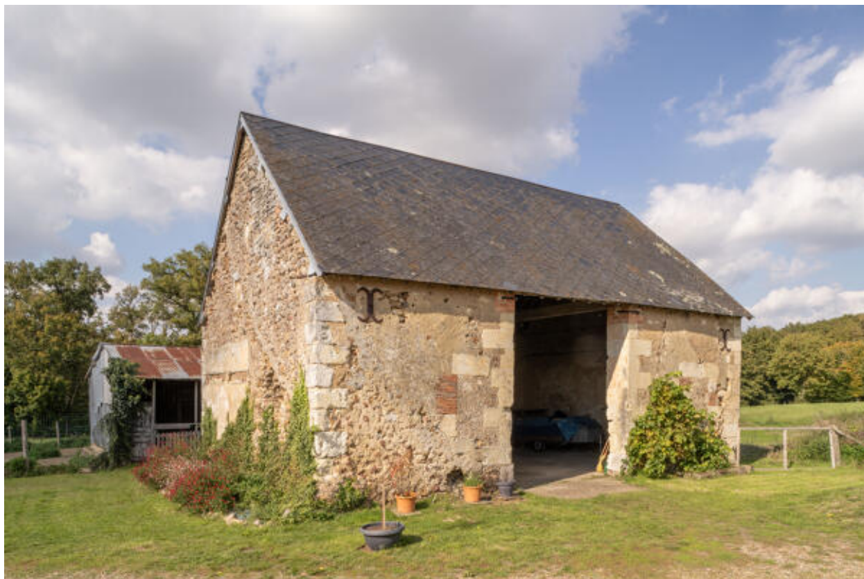
Ancien logis transformé en grange : vue de biais.
