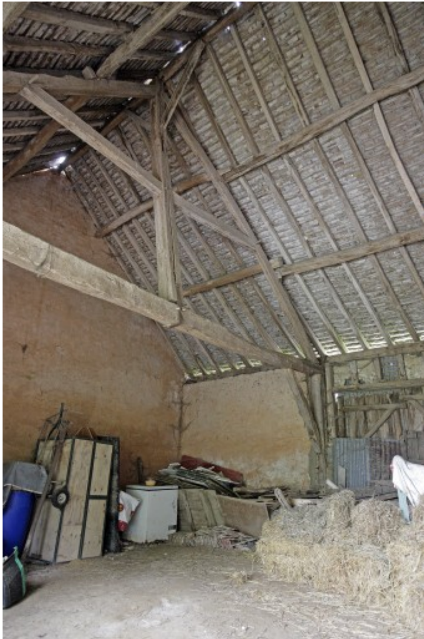
Grange-étables-remise, vue intérieure.
