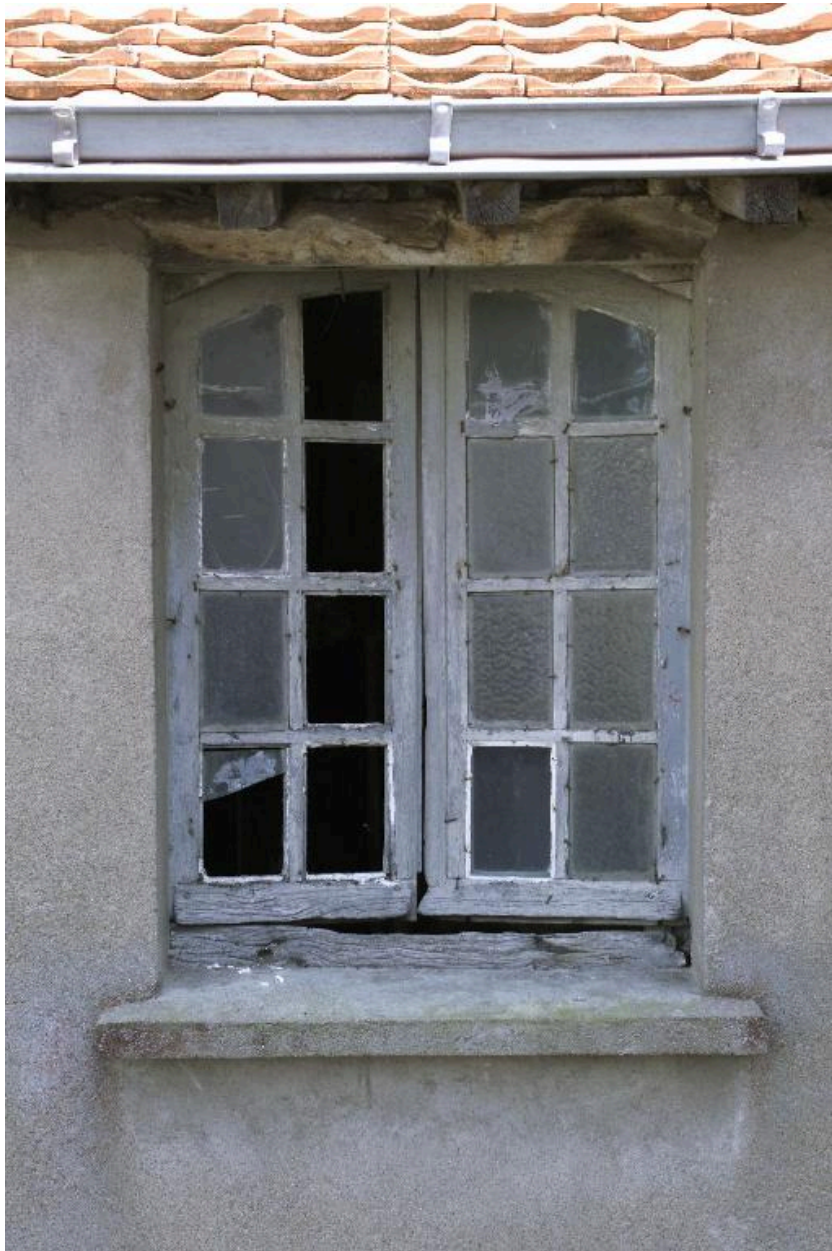
Le corps secondaire, détail d'une baie de l'étage de comble.
