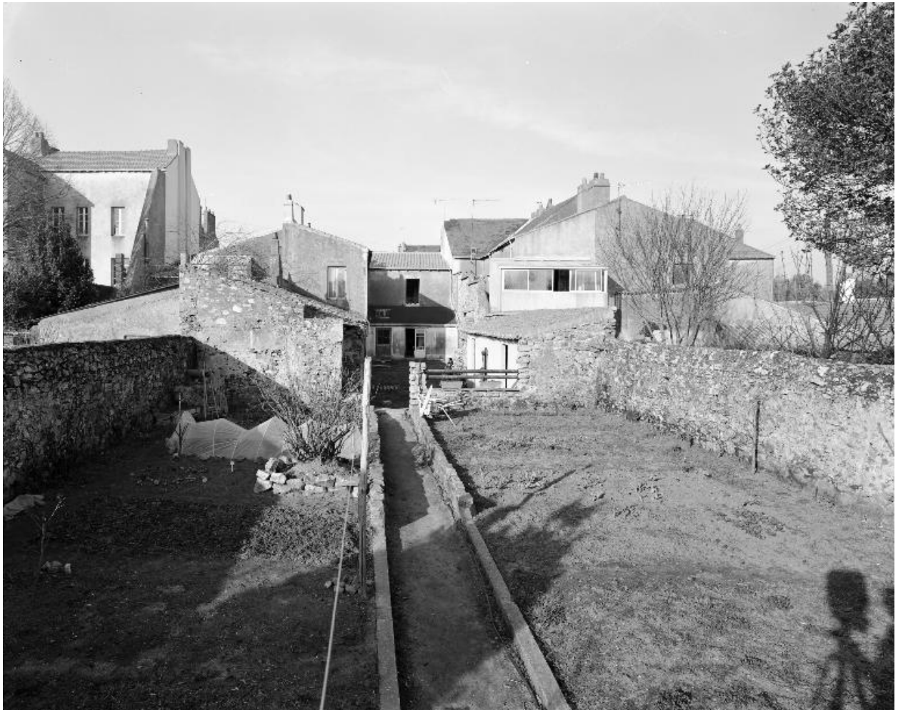
Les façades postérieures des maisons n° 1 à 7 rue Pierre-Jubau, vue prise du jardin de la maison n° 5.
