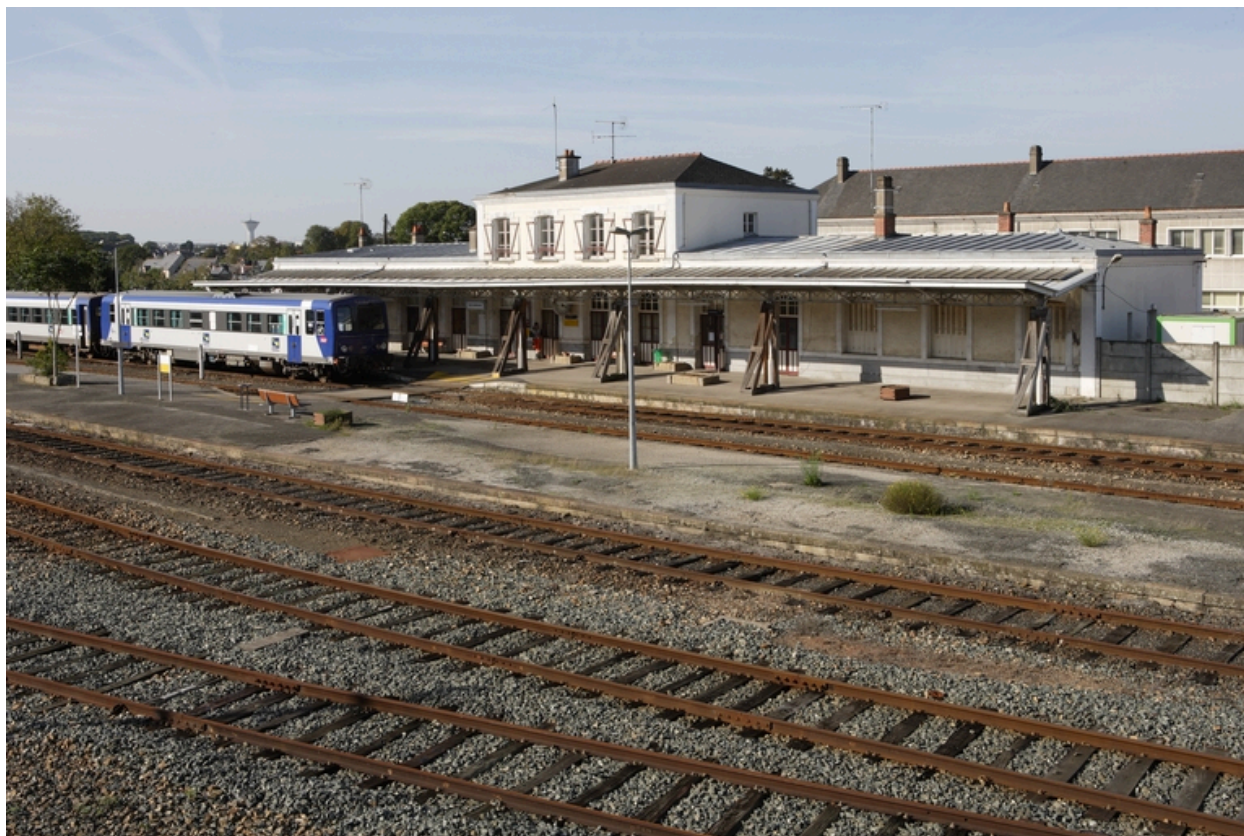
Gare de Châteaubriant, côté quais.
