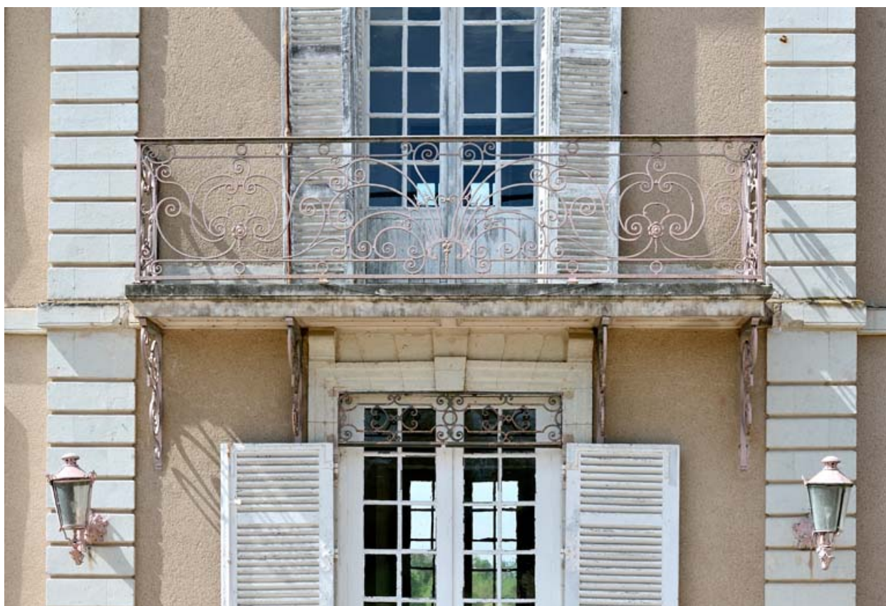
Mantelon. Façade est. Travée centrale. Détail du balcon.
