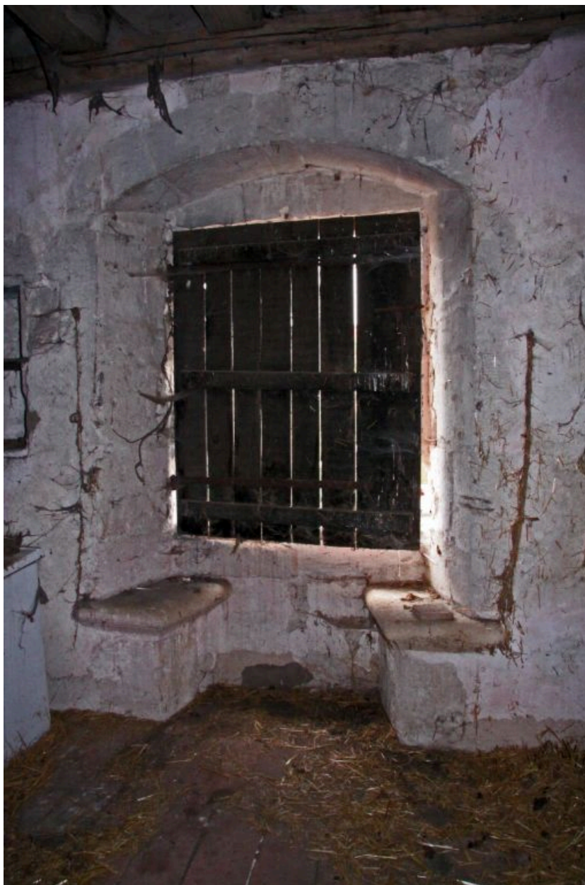
Le logis, façade O sur la cour, 1er étage, détail : revers de la croisée à coussièges.
