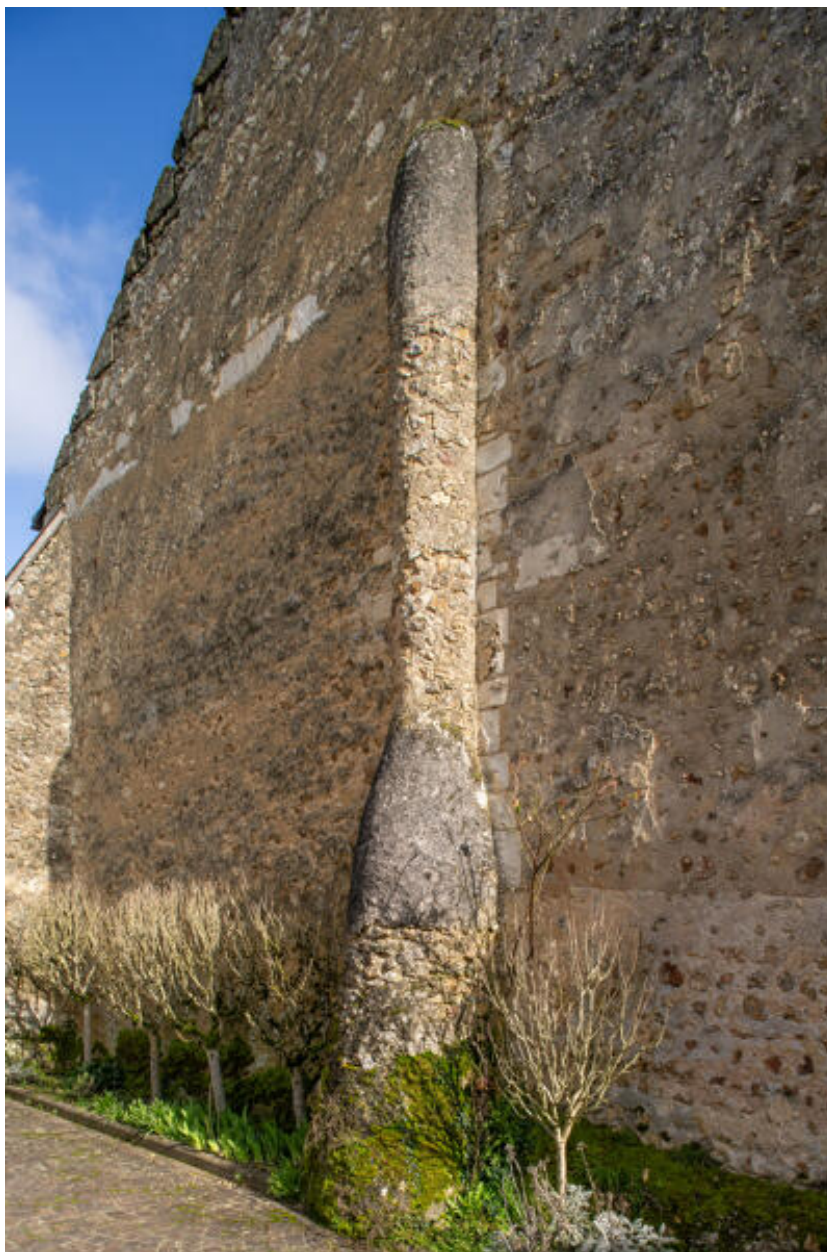
Contrefort hémicirculaire du pignon ouest.
