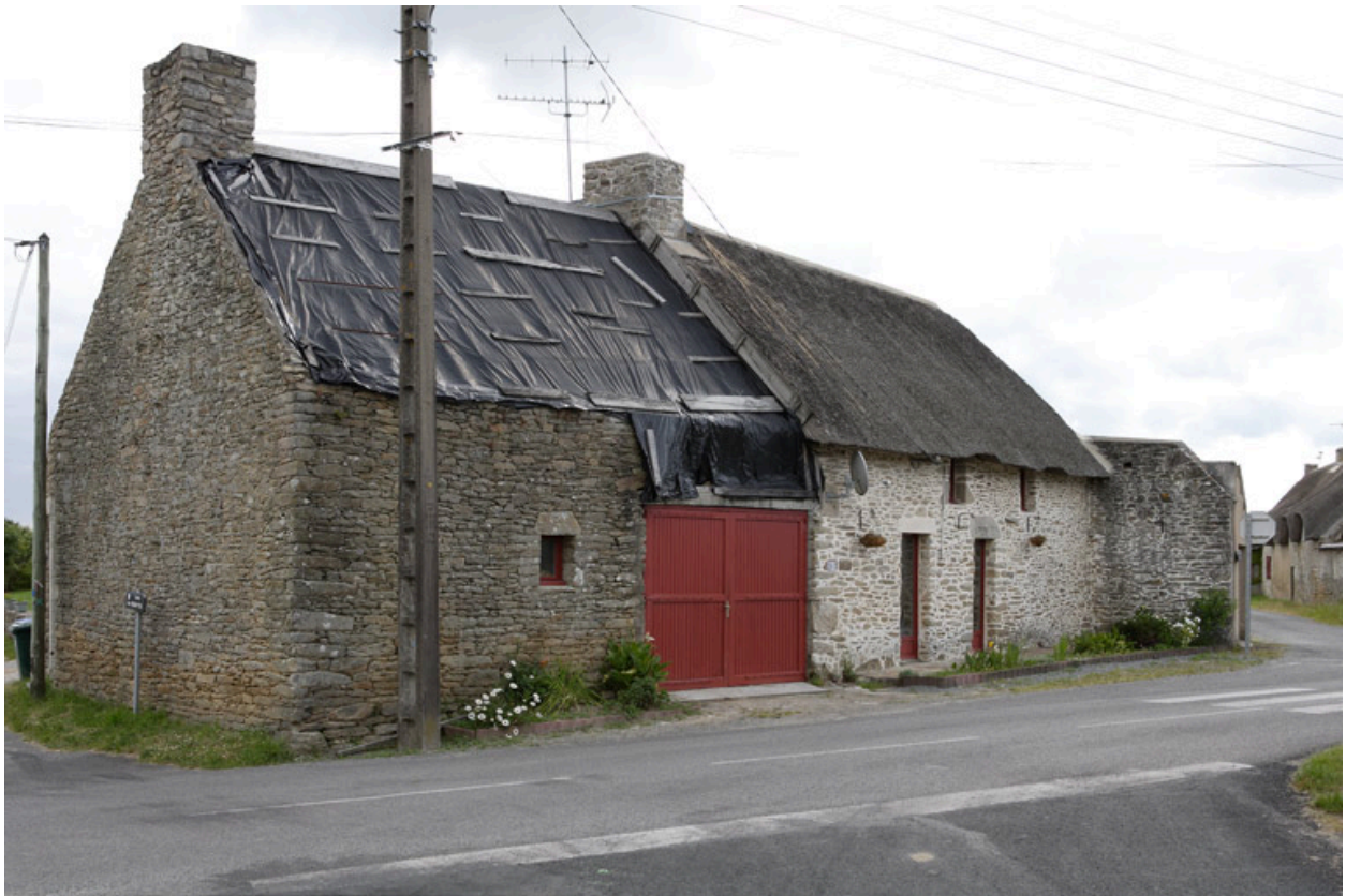
Vue depuis le sud-ouest.
