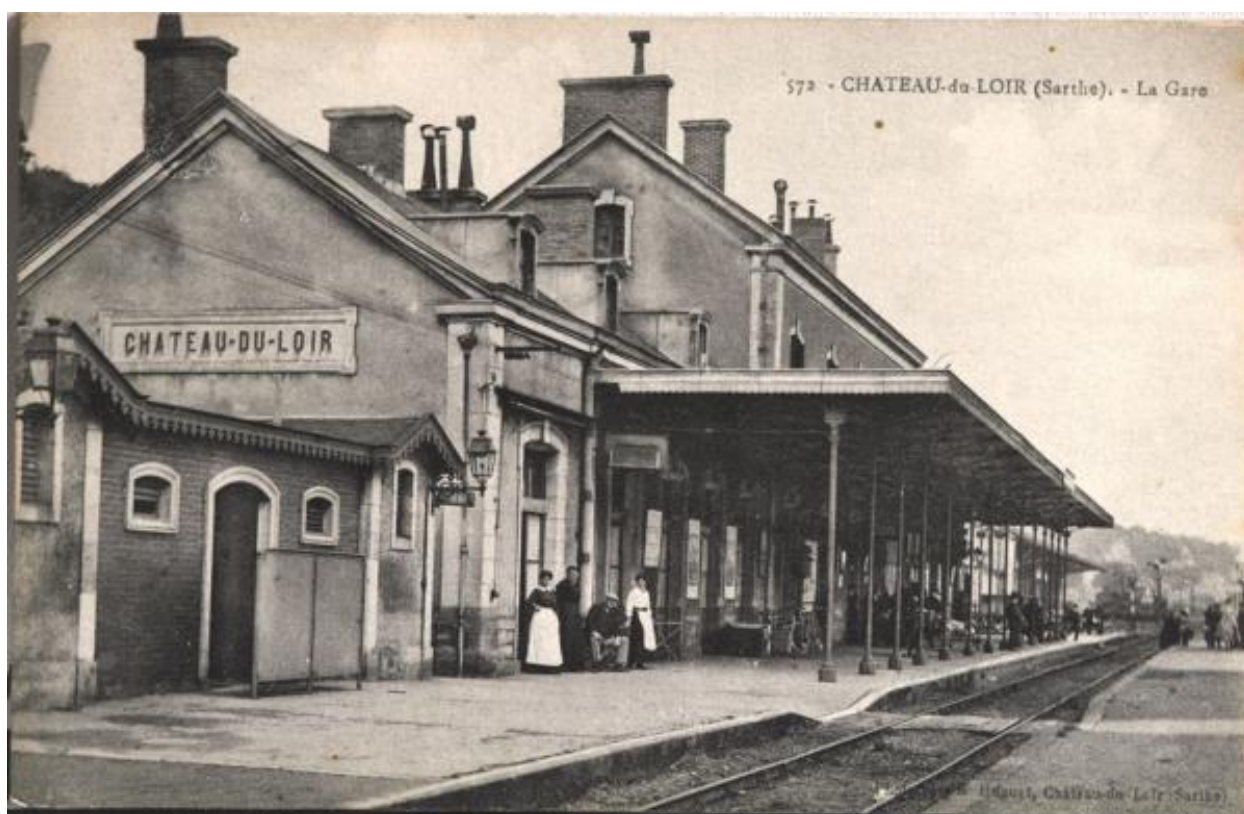
Vue ancienne de la gare de Château-du-Loir.
