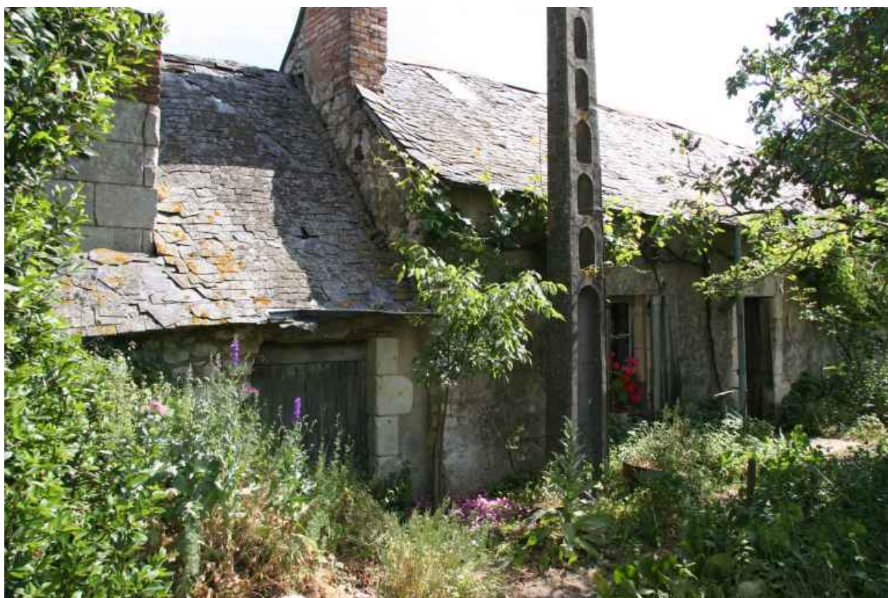
Façade antérieure sur cour.
