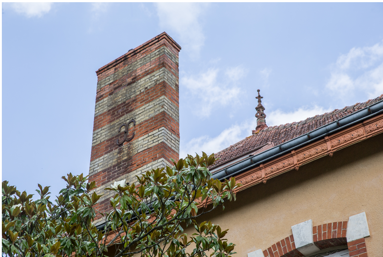
Un détail de la toiture du logement patronal.
