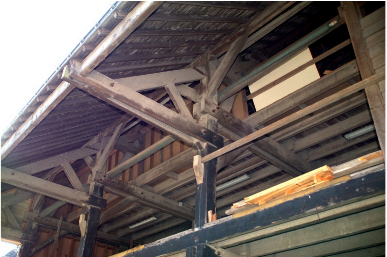
Détail de toiture du hangar flanquant le bureau.
