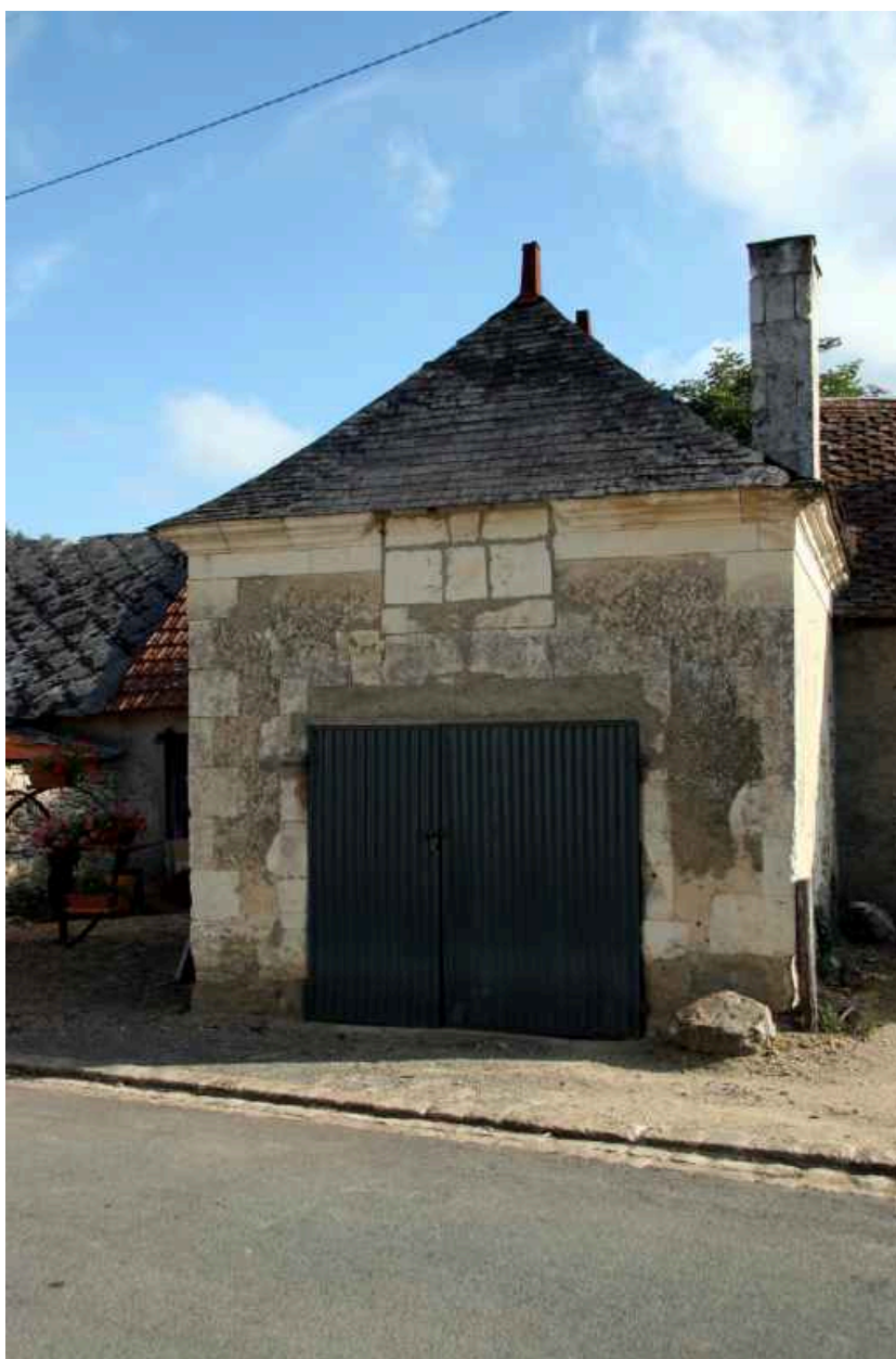
La maison 8 remaniée en garage.
