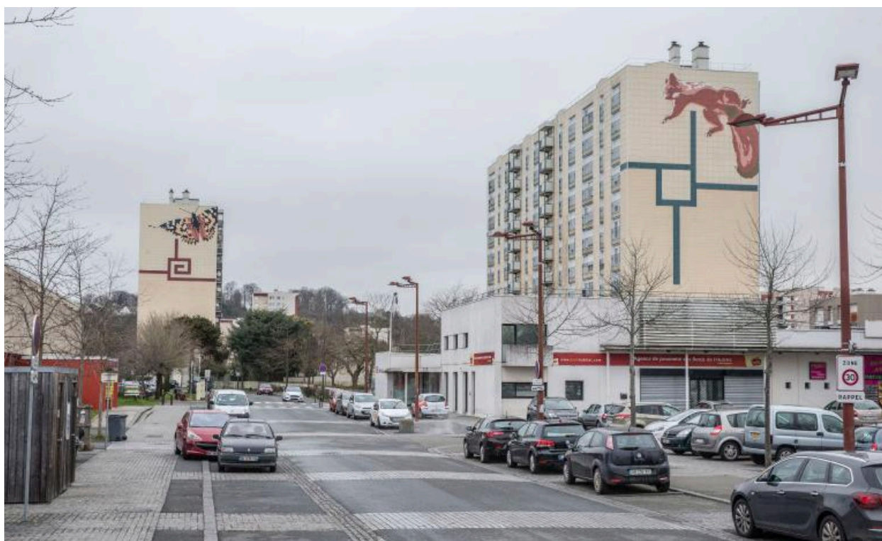
Vue de la rue du Cantal depuis la place du centre commercial des Sablons.
