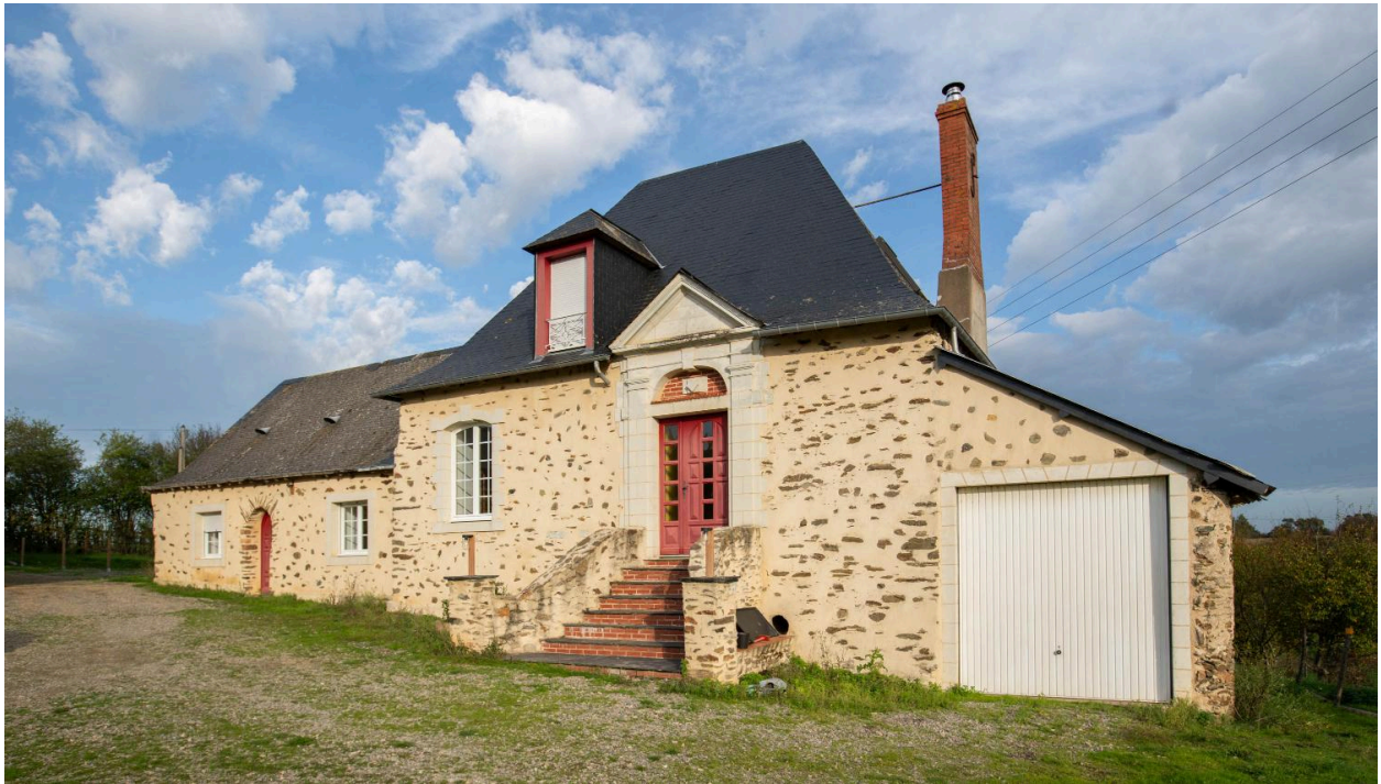
Le corps d'habitation, élévation sur cour.
