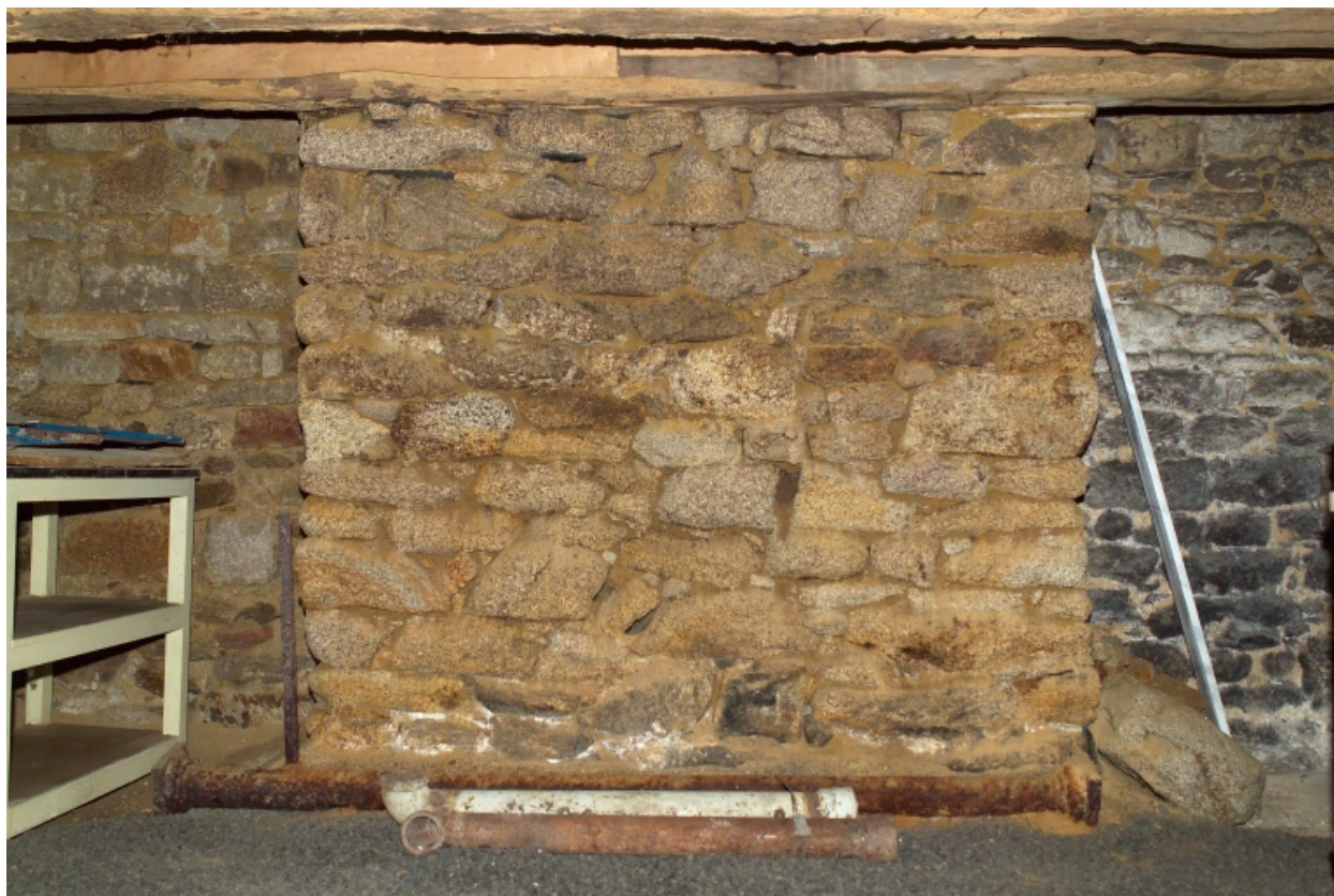
Soubassement de cheminée dans la cave.
