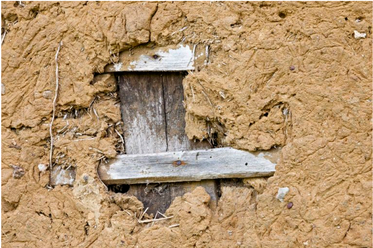
Détail du hourdis de torchis de l'élévation postérieure.
