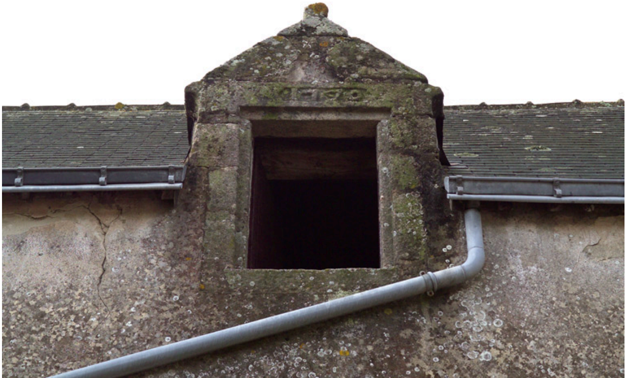
Aile sud, façade nord, détail de la lucarne.
