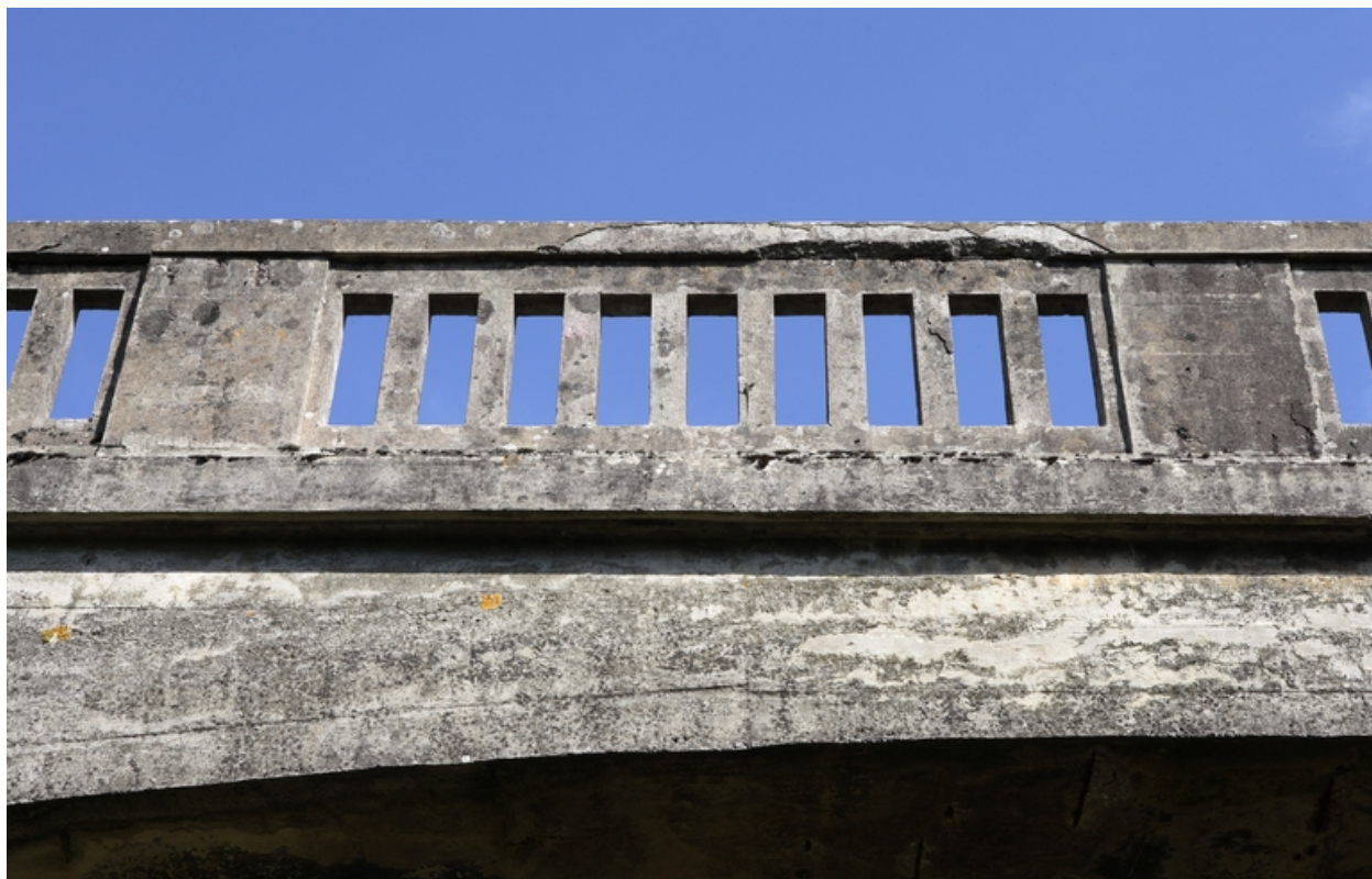
Garde-corps en béton ajouré.
