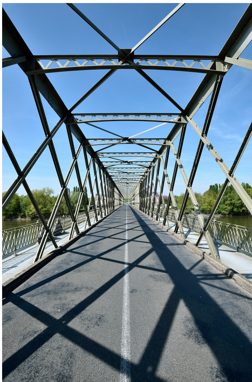
Vue vers Béhuard. Barres métalliques triangulées.
