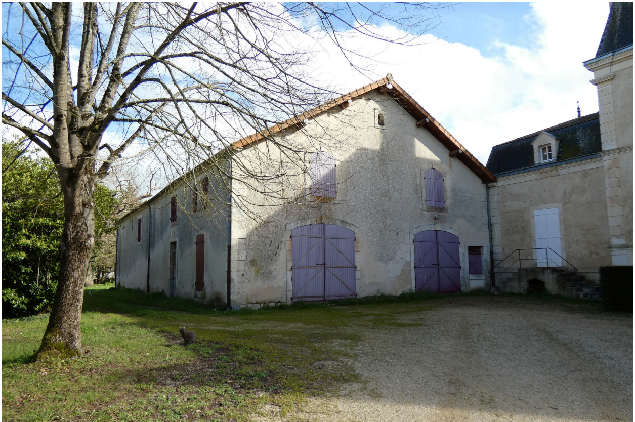
Le corps de ferme vu depuis le nord-ouest.
