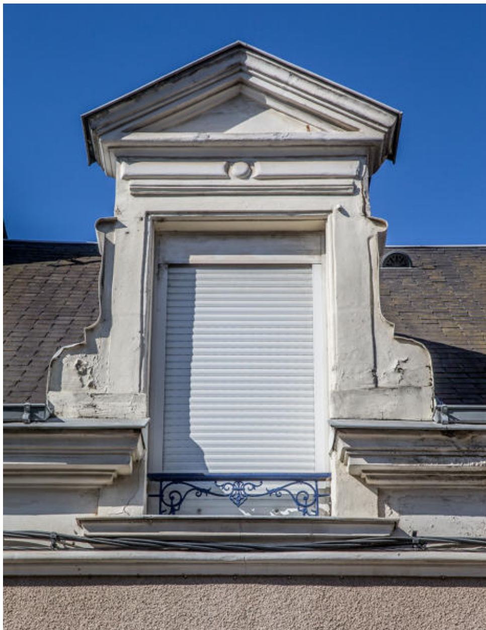
Vue d'une lucarne de pierre avenue Olivier-Heuzé.
