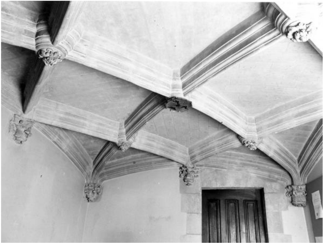
Corps d'escalier, 1er niveau, vestibule entre les deux corps : vue d'ensemble avec la voûte et la porte d'accès au corps de logis droit.
