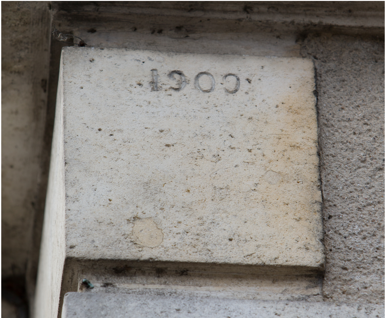
Un détail de la façade principale, la date portée.
