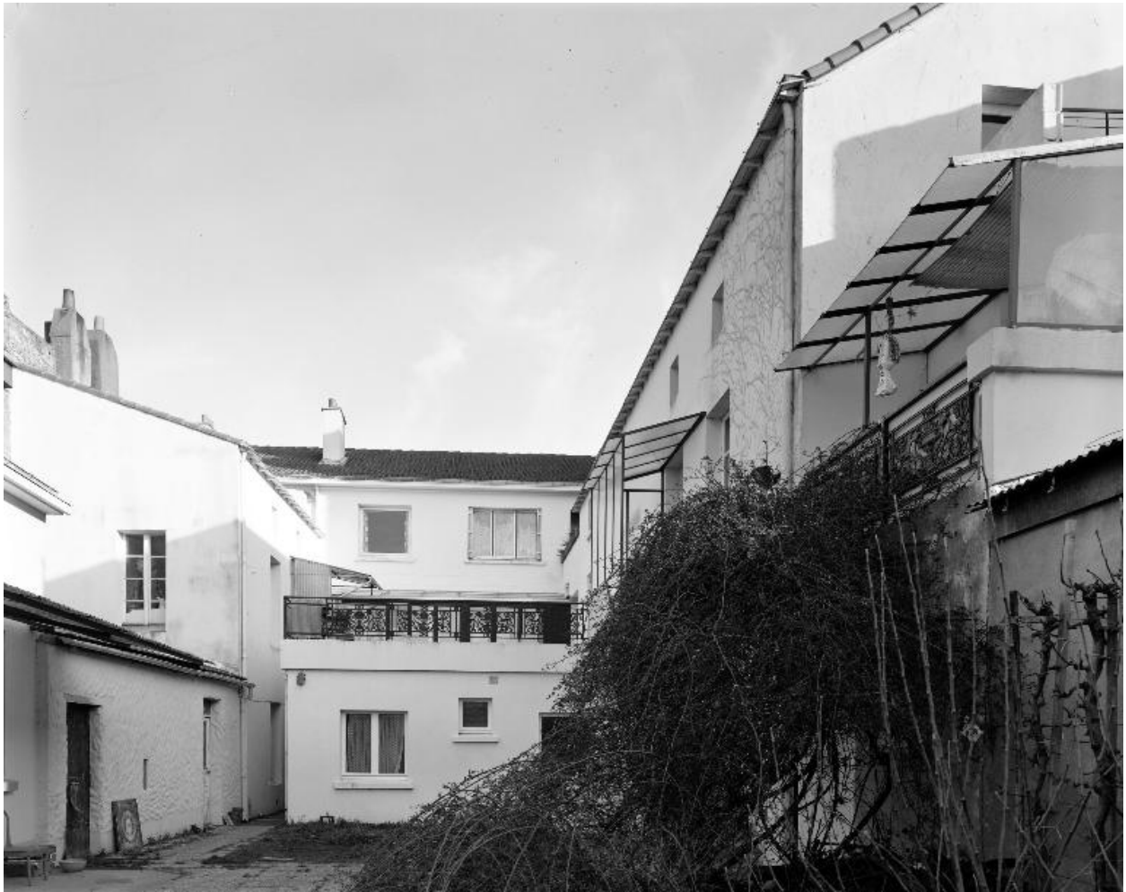
La maison n° 29 rue Pierre-Jubau, vue prise depuis la cour.
