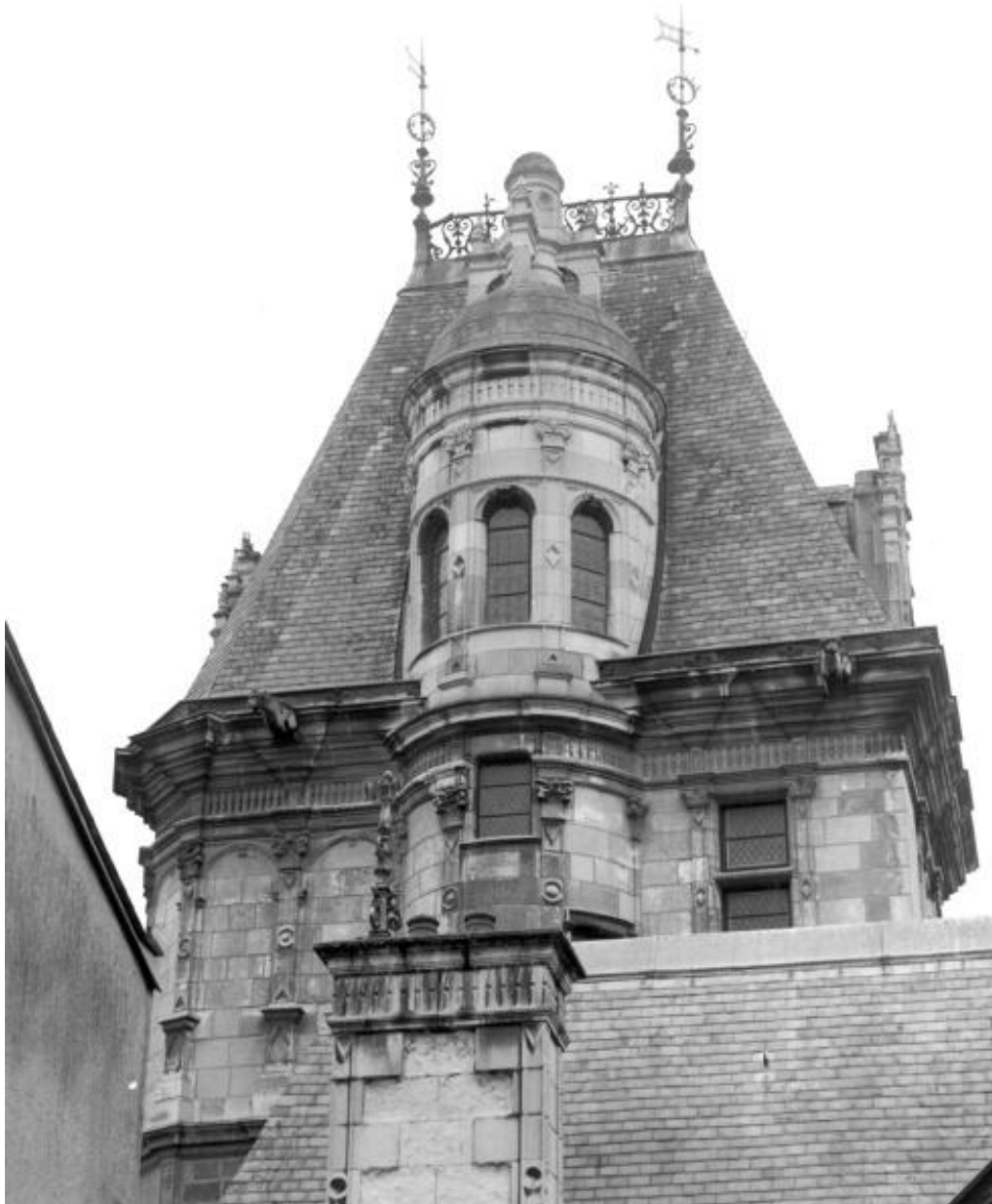
Corps d'escalier, élévation latérale droite, partie haute.
