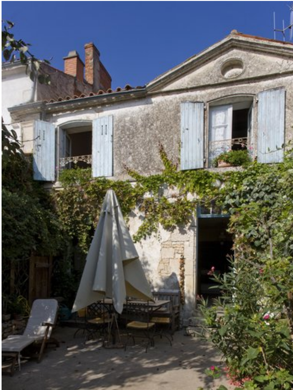
Vue de la façade principale, donnant au sud.
