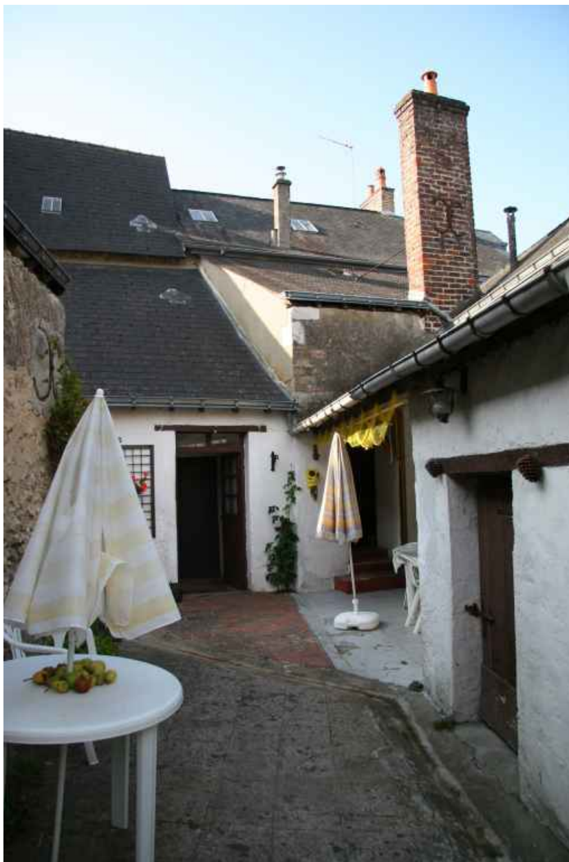
Façade sur la cour masquée par des appentis multiples.
