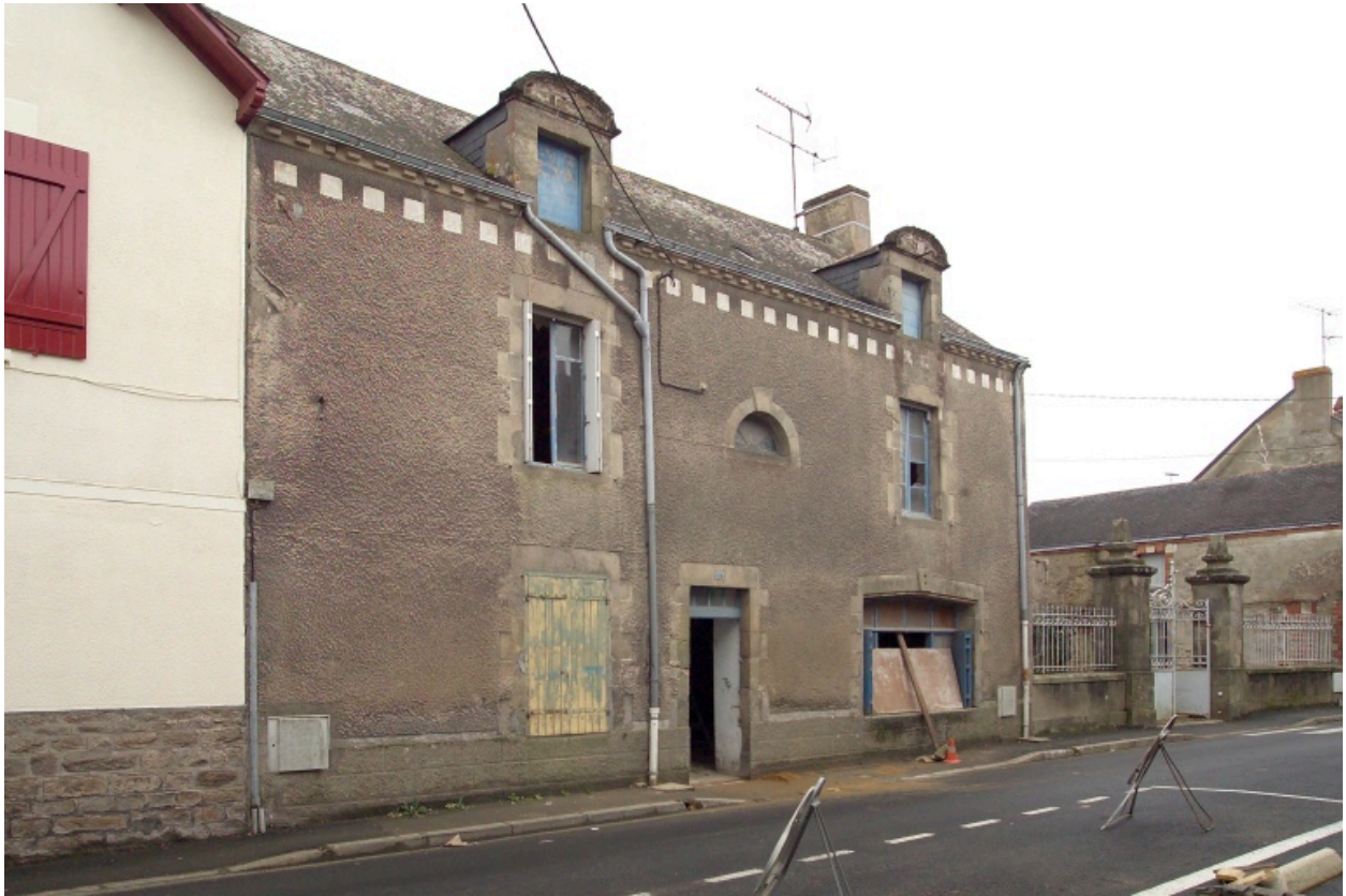
Vue de la façade sur rue.
