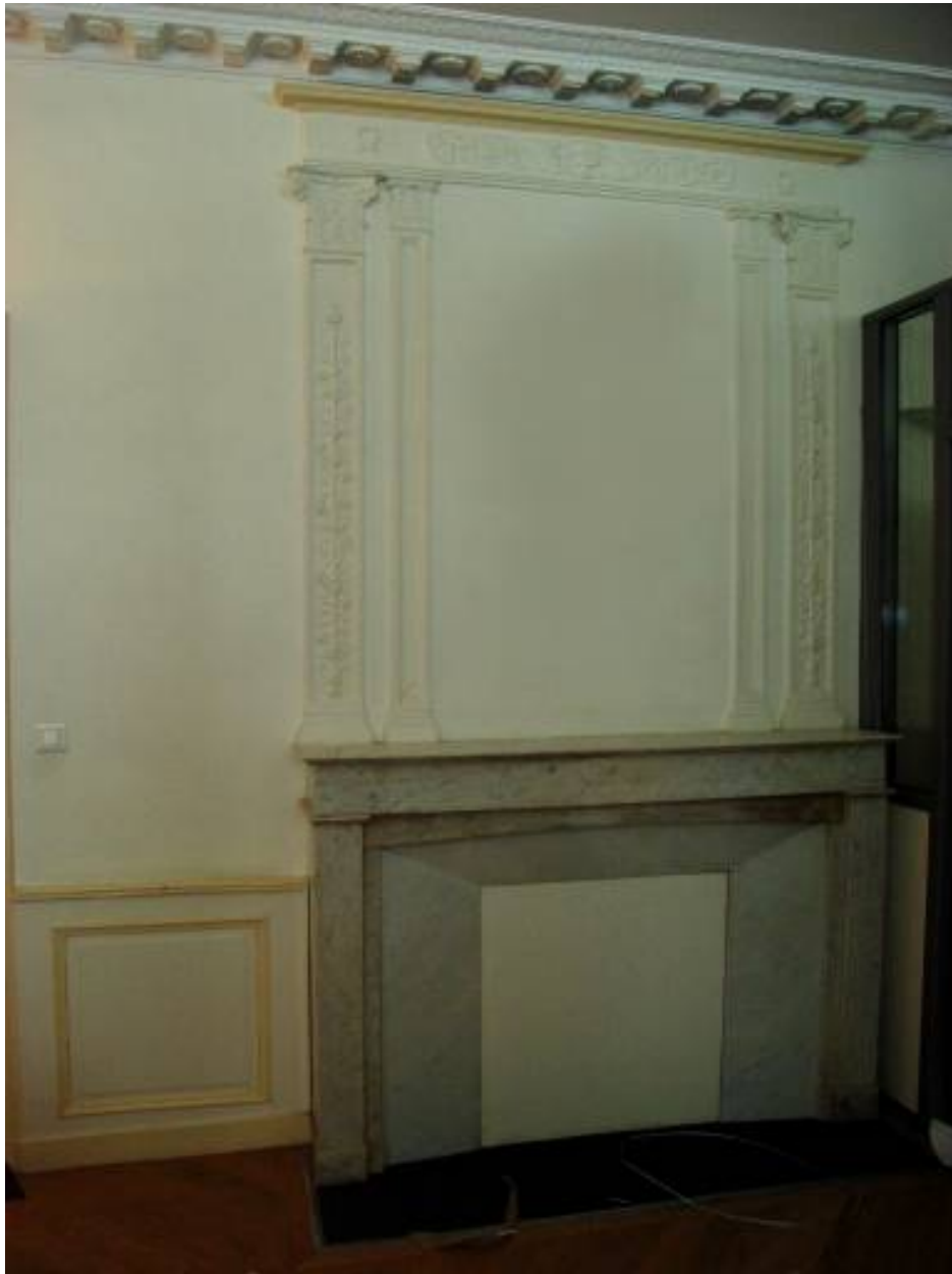
Vue de la cheminée du salon est au rez-de-chaussée.
