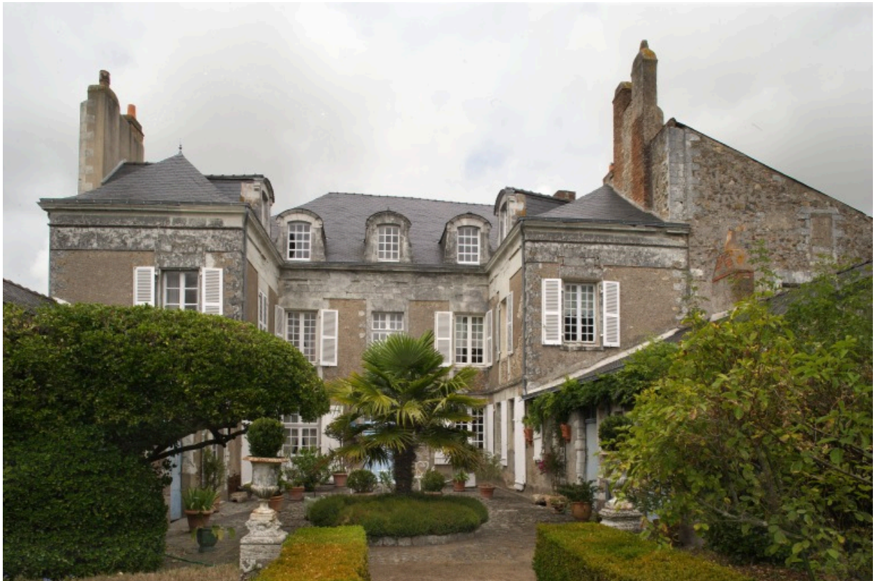
Vue d'ensemble depuis le jardin.
