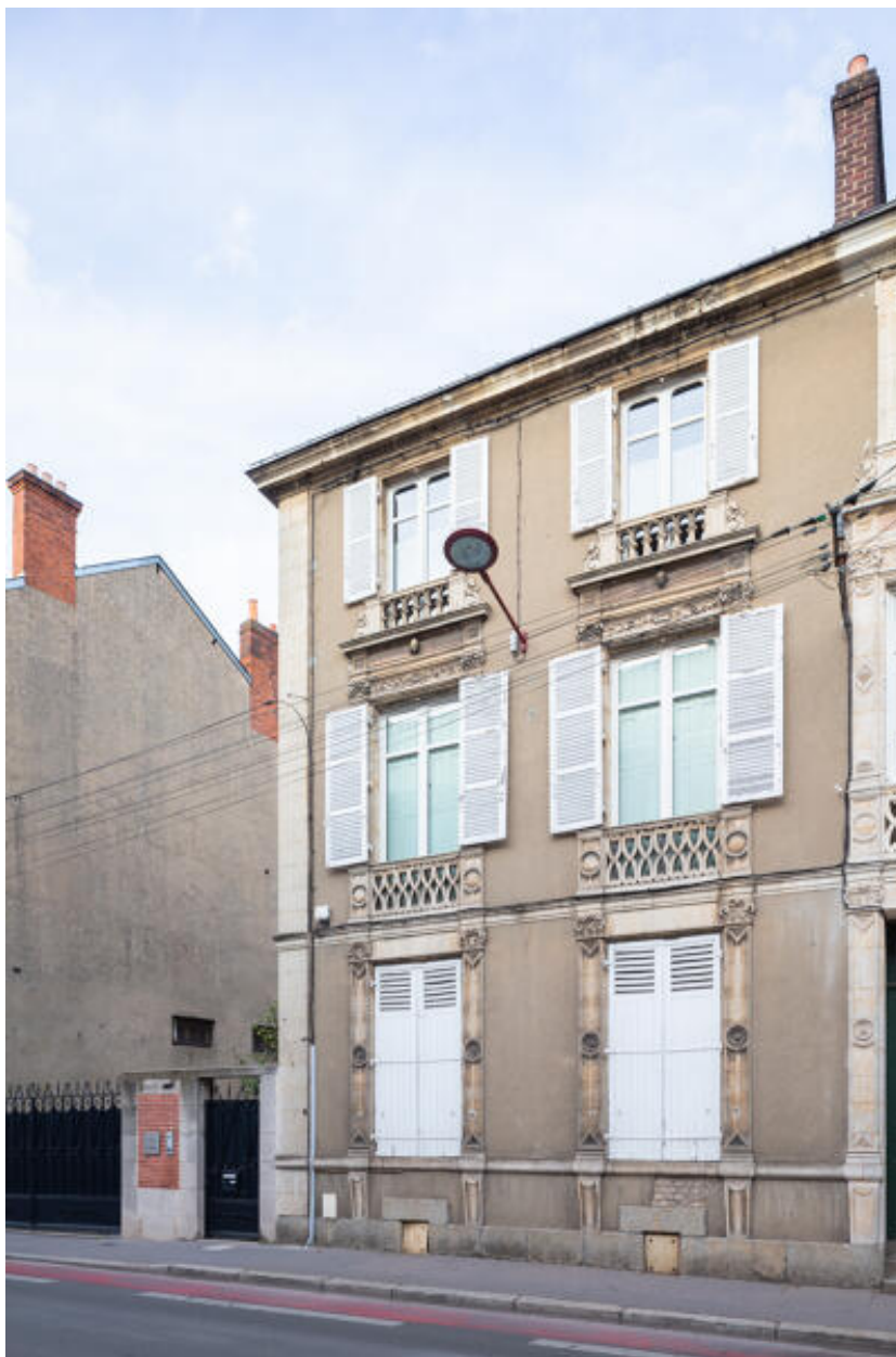
Vue des deux travées nord de la maison depuis le sud.
