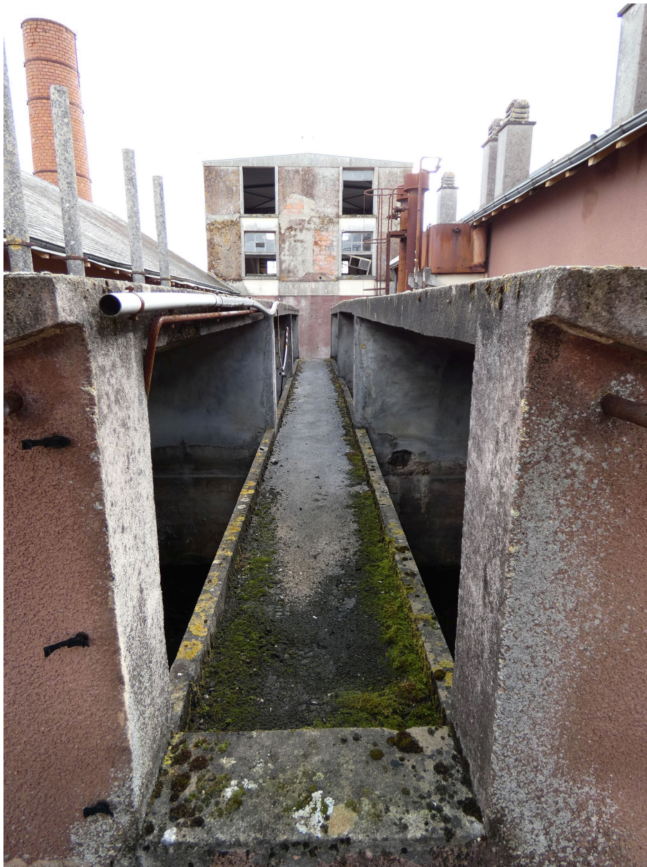
Les bacs à eau sur le toit en terrasse du bâtiment des chambres froides, vus en direction de l'est.
