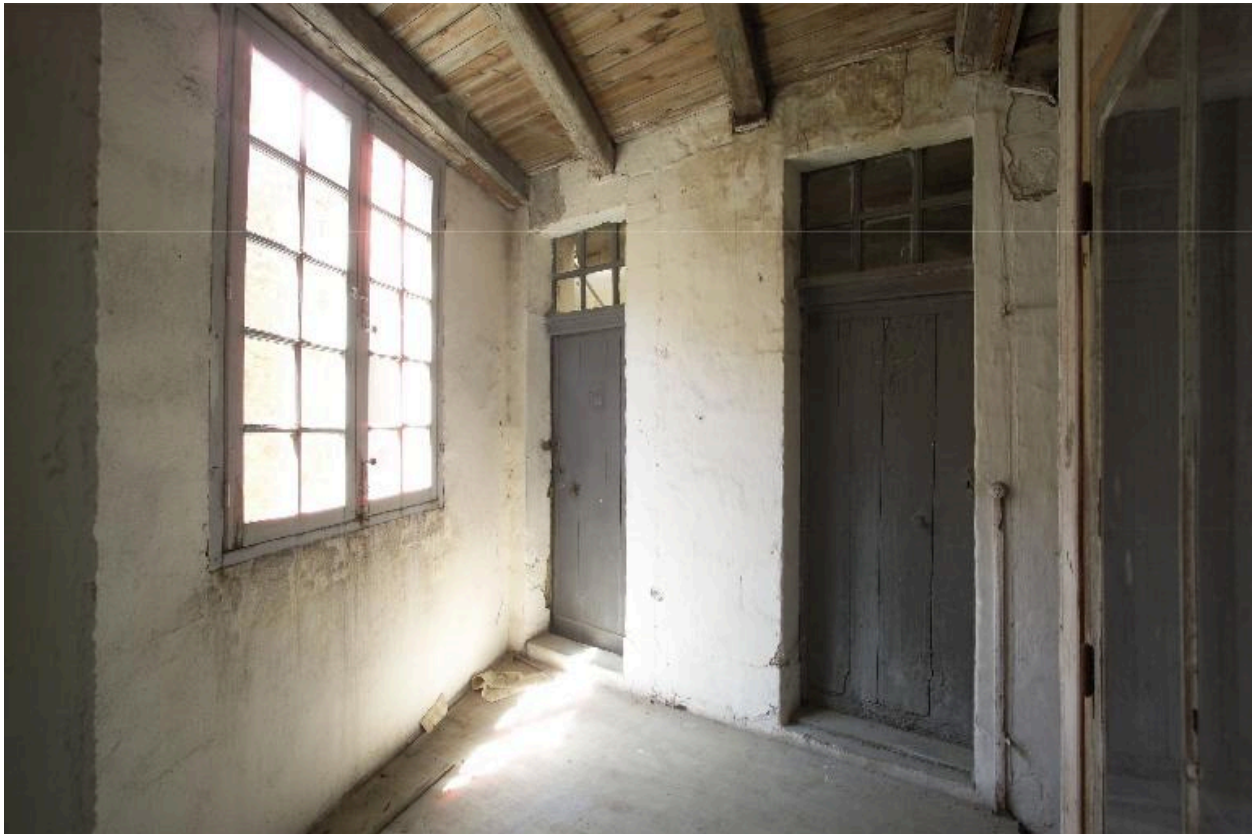
L'escalier, vue des portes palières du deuxième étage du corps principal.
