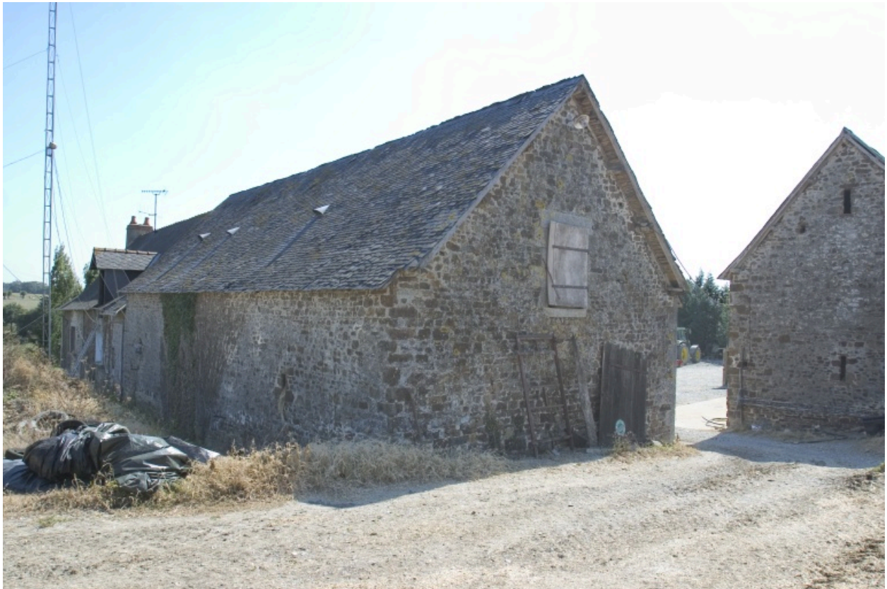
Le logis-étable vu depuis le nord-ouest. A droite, le pignon de l'étable-grange.
