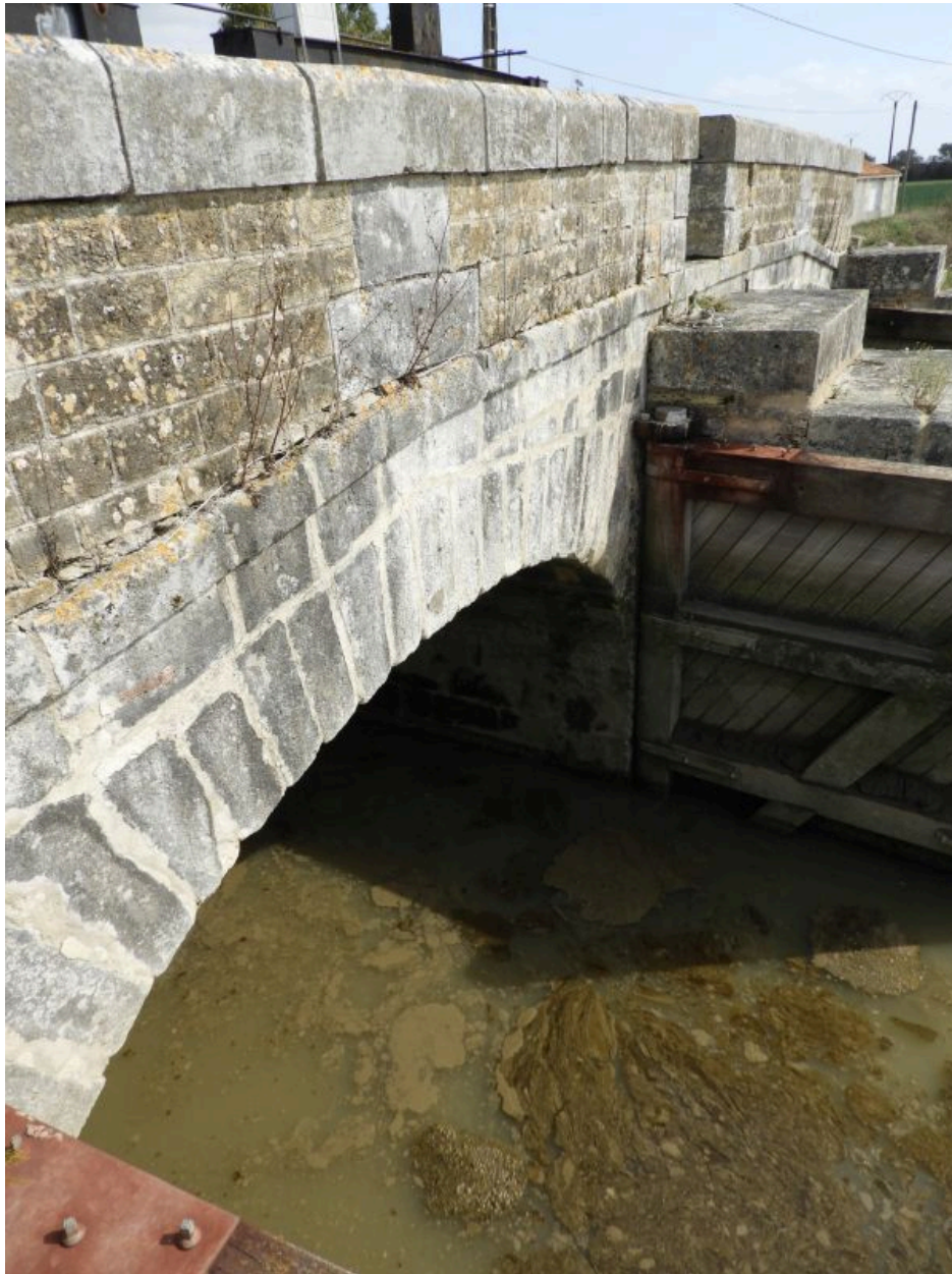
La sortie côté aval du pertuis de la porte ouest.
