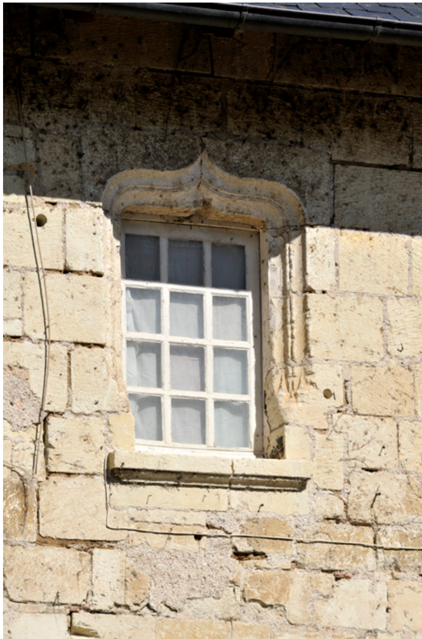
Baie de l'étage, avec linteau à accolade.
