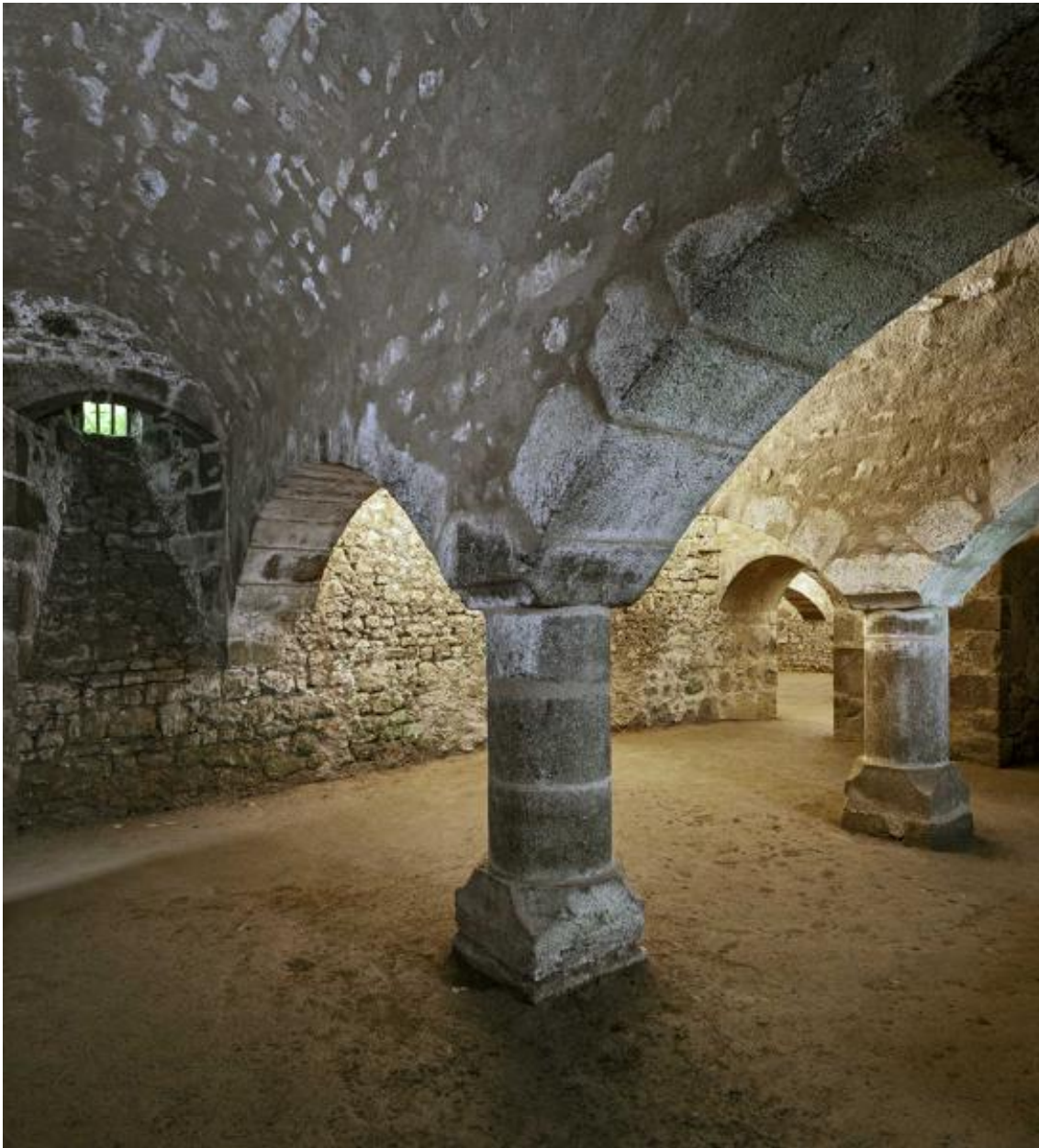
Cave du corps de logis nord-ouest.
