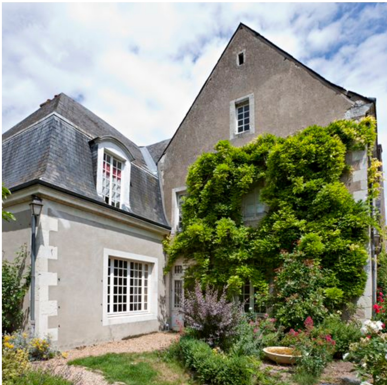
Pignon sur la cour et bâtiment de service.
