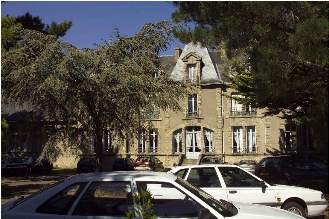
Depuis le parking, vue de la villa Château Pavie.
