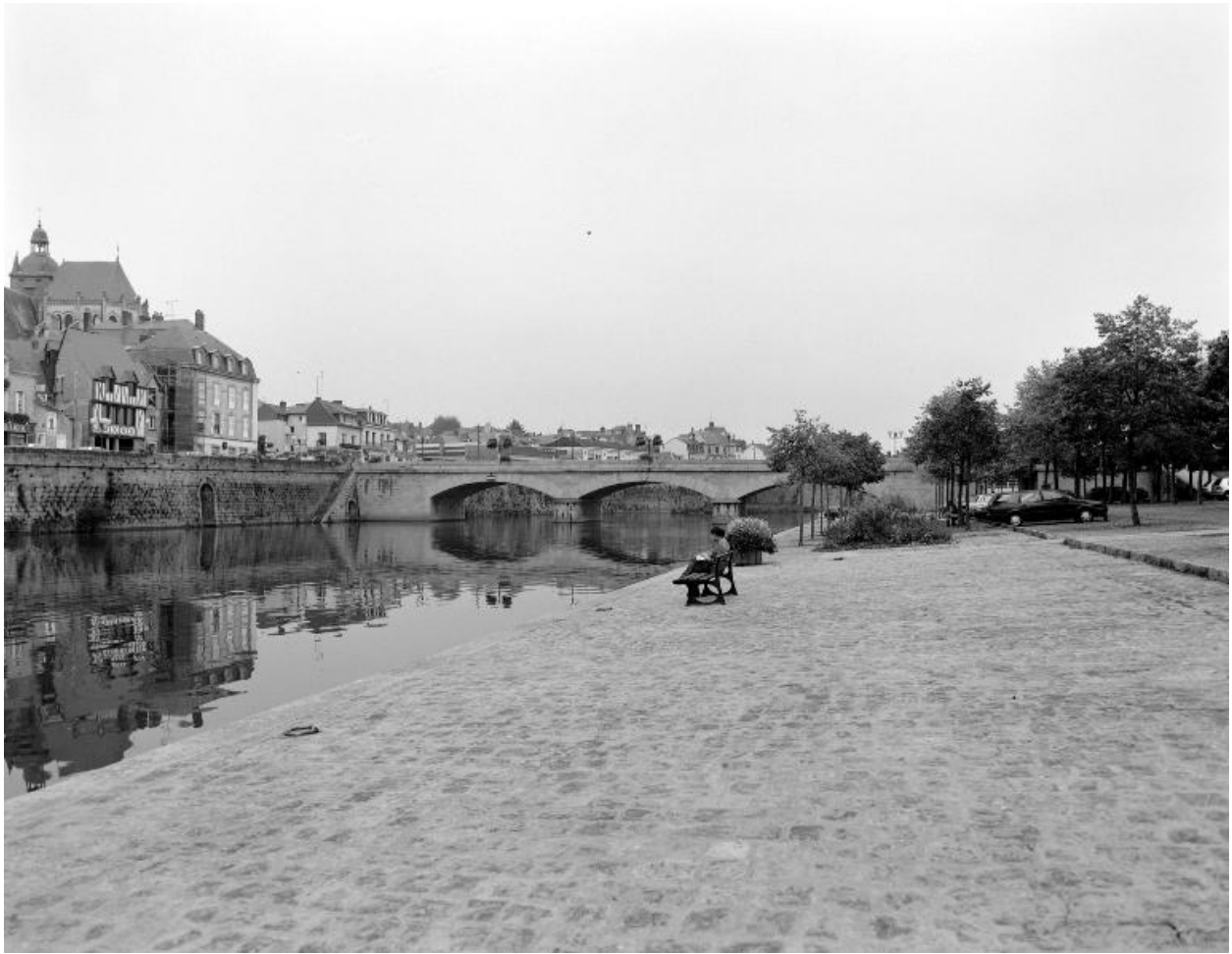
Vue d'aval depuis le port.
