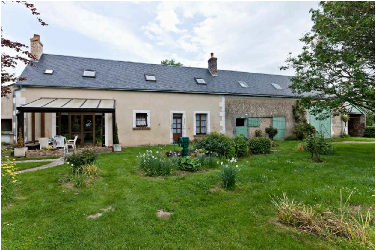
Ferme bloc à terre : façade antérieure (sud).
