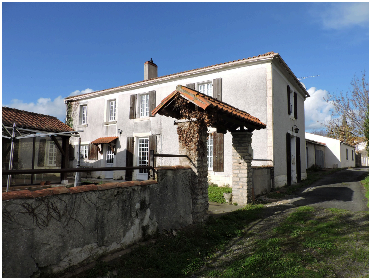
Vue depuis le sud.
