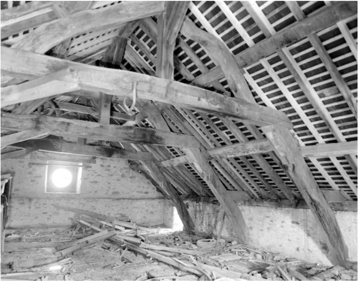
Le comble du moulin, vu de l'ouest.
