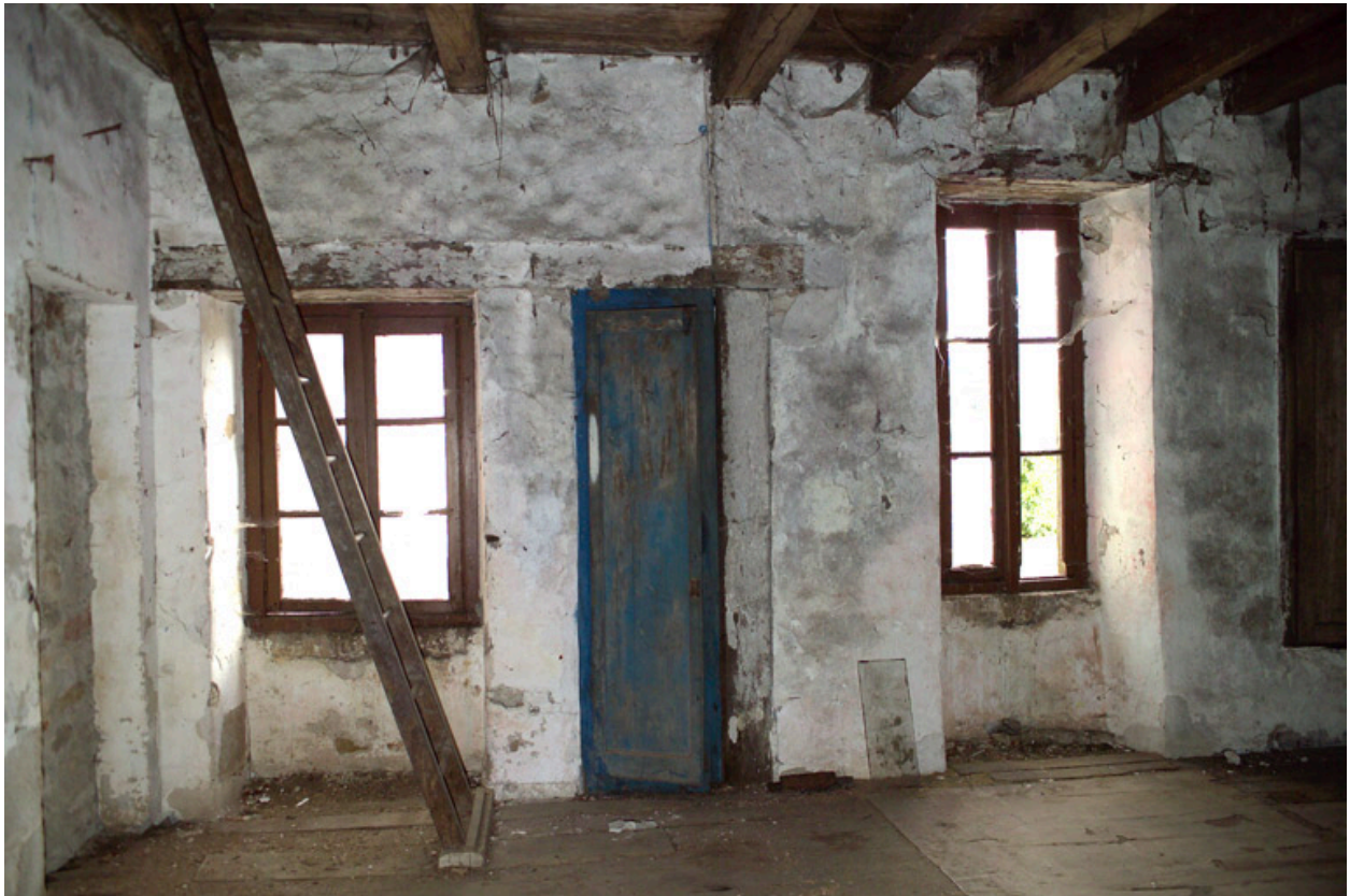
Aile sud, pièce orientale, premier étage, vue vers le nord.
