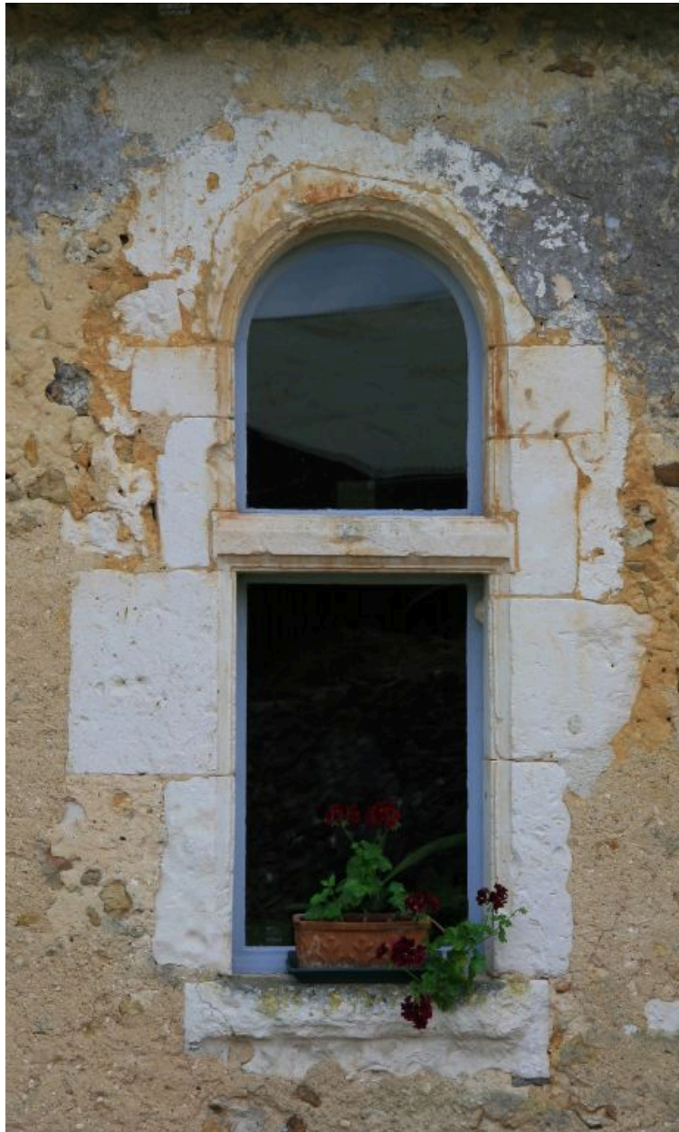
La maison, façade postérieure, détail : baie centrée, milieu XVIe siècle.
